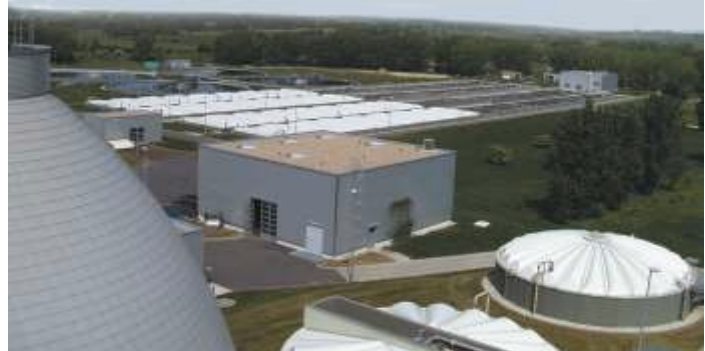
Statia de epurare a apelor reziduale "Halle Nord" (Germania)
